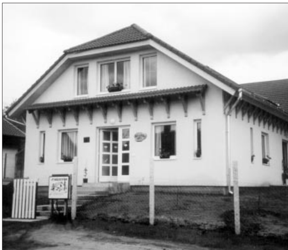
Az igényesen kialakított új műhely épülete
